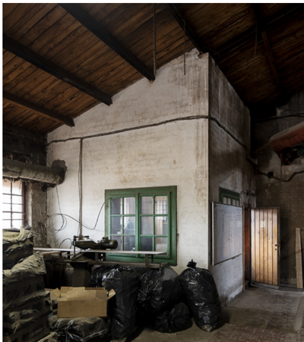
Kantorek w budynku klinkierni.
